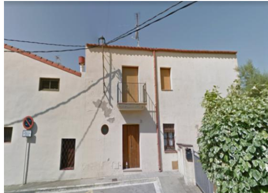
Recollida d'aigua de pluja de la coberta i abocada directament al carrer
