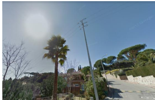
Xarxa elèctrica aèria d'e mitja i alta tensió al incorporar-se al sòl urbà
