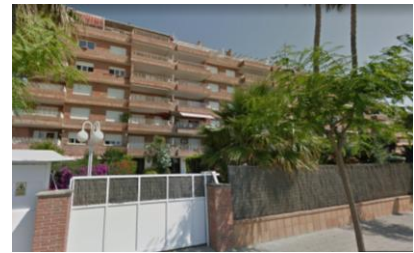
Bloc aïllat al passeig del Marquès de Casa Riera
