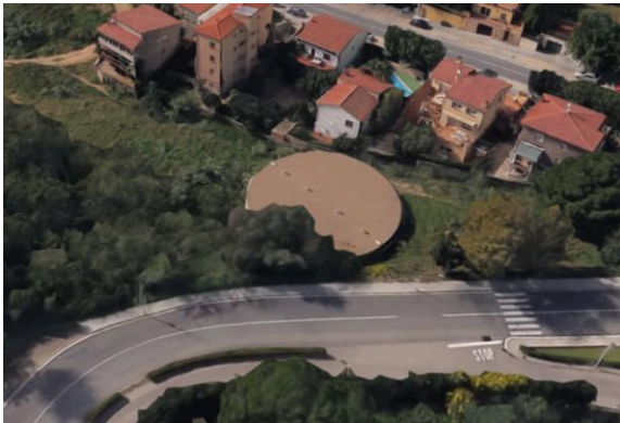
Dipòsit d'abastament d'aigua potable
