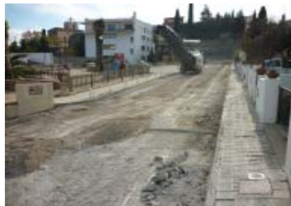
Asfaltat c/ Josep Brunet
