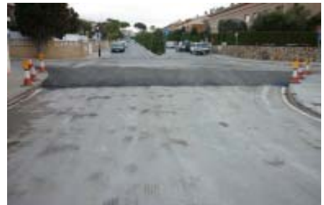
Pas elevat entre els carrers Oliveres i Palmeres
