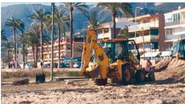
Les excavadores ja estan remouent la sorra de la zona del passeig que s'ha de remodelar ■ R.M.B.
