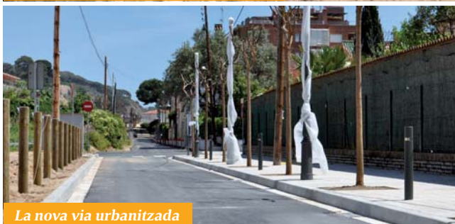
El carrer de la Pau abans de les obres
