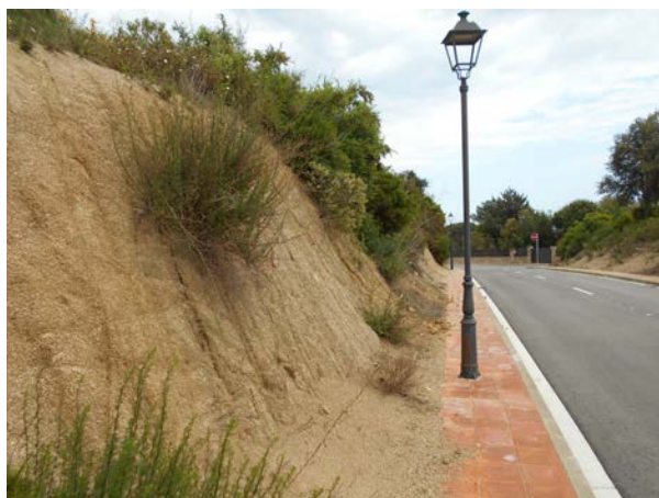
Imatge 14. Detall del tram final de l'Avinguda Supermaresme amb saulons esllavissats sobre la vorera.
