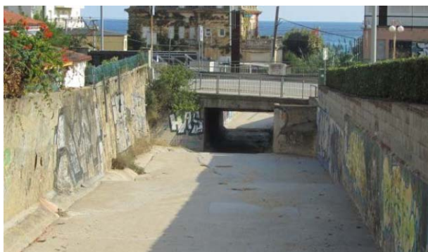
Imatge 9. Pas del torrent del Gorg per sota de la via de la N-II. Font: Estudi d'inundabilitat. ICGC (2017).
