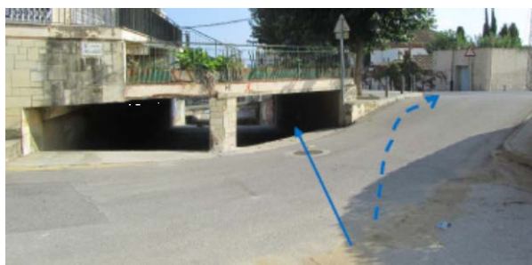
Imatge 7. Tram cobert del torrent del Gorg entre els carrers del Pont del Sergent i Pau Casals la Isla. L'aigua desborda cap al marge dret, on es troba algun punt més baix respecte de l'estructura.
