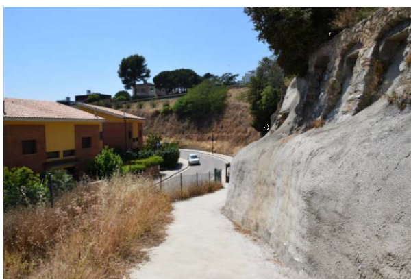
Imatge 16. Detall de les obres d'estabilització del talús (gunitat i reforç) al peu de la torre de guaita de Can Valls.
