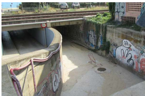
Imatge 10. Pas del torrent del Gorg per sota de la via del tren. Font: Estudi d'inundabilitat. ICGC (2017).
