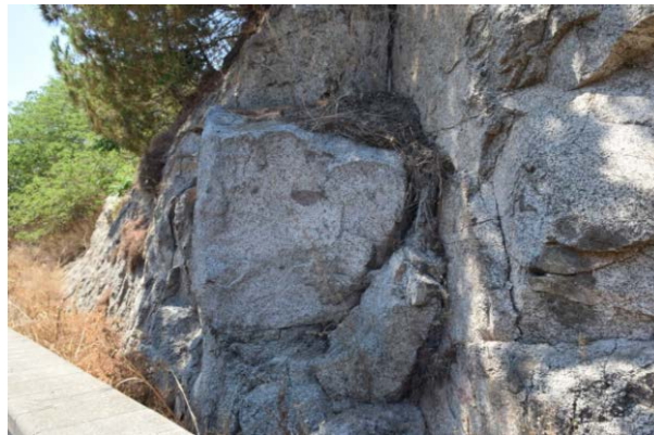
Imatge 17. Detall del talús a peu de la torre de guaita de Can Valls on s'observa la individualització d'un bloc degut al diaclasat del massís i l'antropització del vessant.
