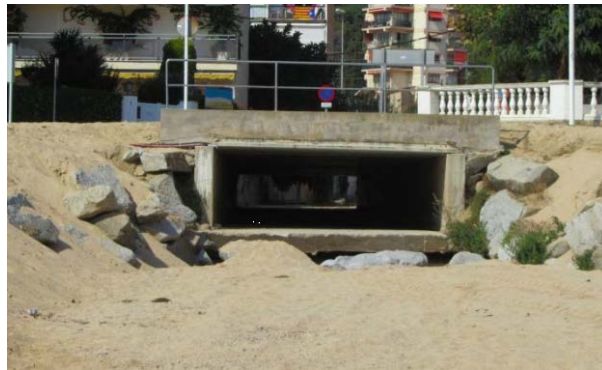
Imatge 11. Pas del torrent del Gorg per sota del passeig marítim. Font: Estudi d'inundabilitat. ICGC (2017).
