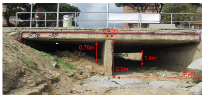
Imatge 6. Pas de la riera de Sant Vicenç per sota del Passeig del Marquès de Casa Riera. Font: Estudi d'inundabilitat. ICGC (2017).
