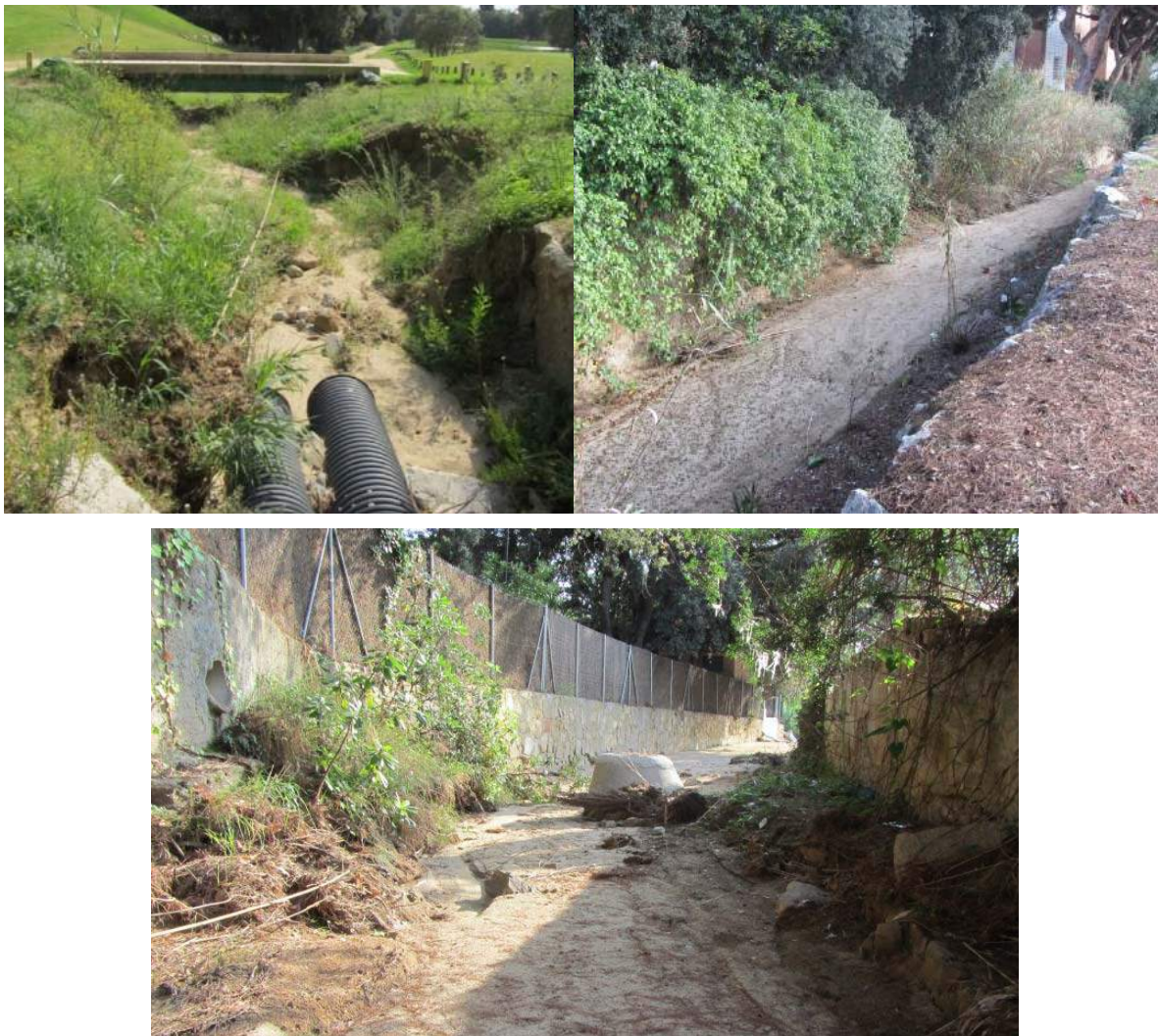
Figura 19. Vista de la llera del torrent de la Gironella, entre el tram del camp de Golf i aigües amunt de la confluència amb la riera de Balís.
