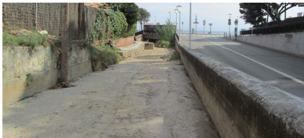
Figura 22. Vista de la llera de la riera de Sant Vicenç en el seu últim tram per zona urbana, abans la desembocadura.
