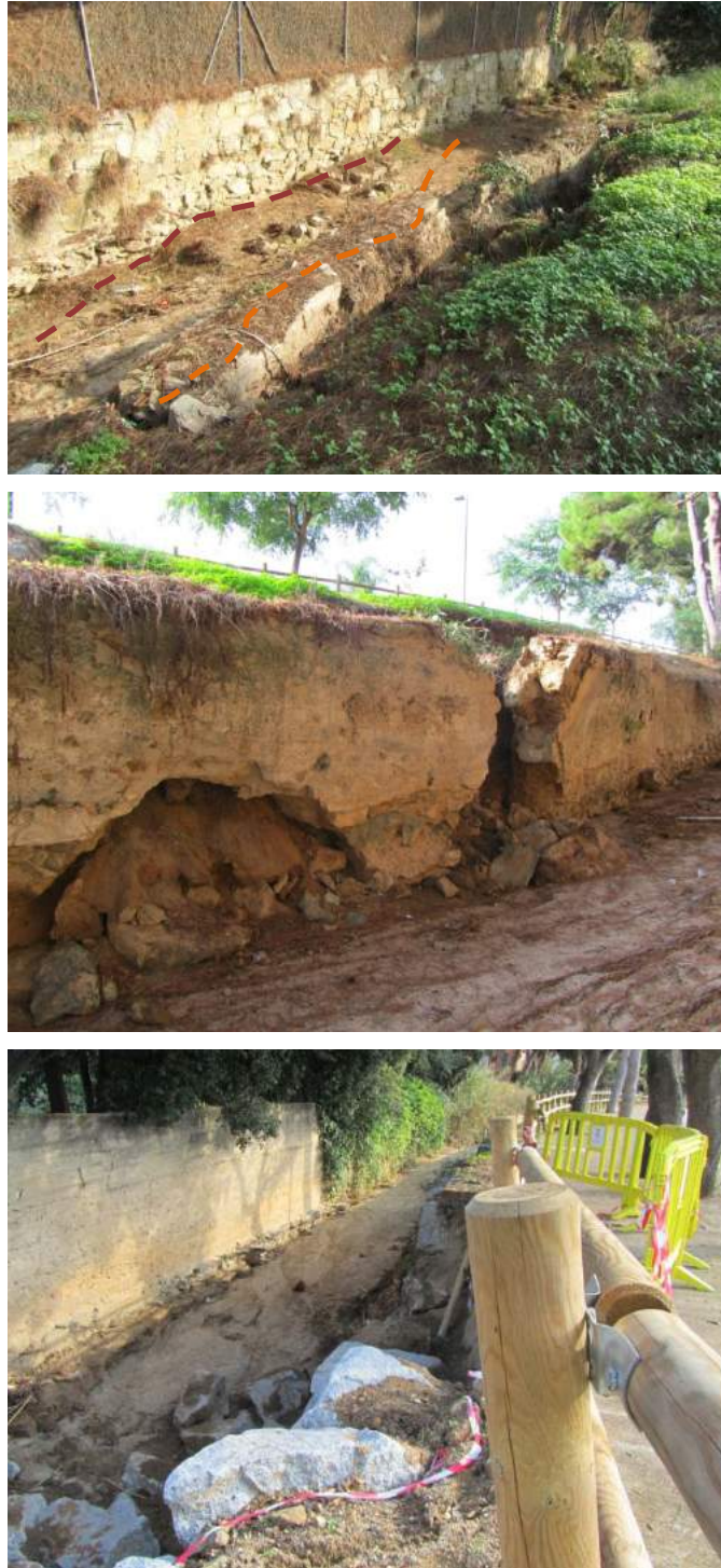
Figura 68. Tram del torrent de la Gironella afectat per socavació i erosió.
