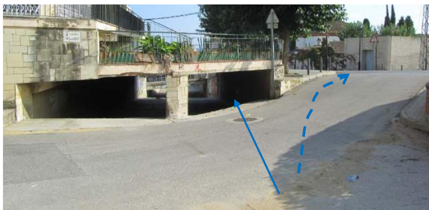
Figura 74. Torrent del Gorg. Estructura GO_04. Desbordament cap a l'àmbit del Centre de Jardineria.
