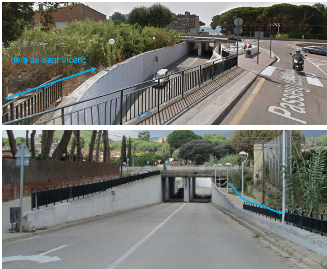
Figura 70. Tram final de la riera de Sant Vicenç. Pas per sota la carretera nacional N-II i la via de ferrocarril. (La figura superior està extreta de Google Maps).
