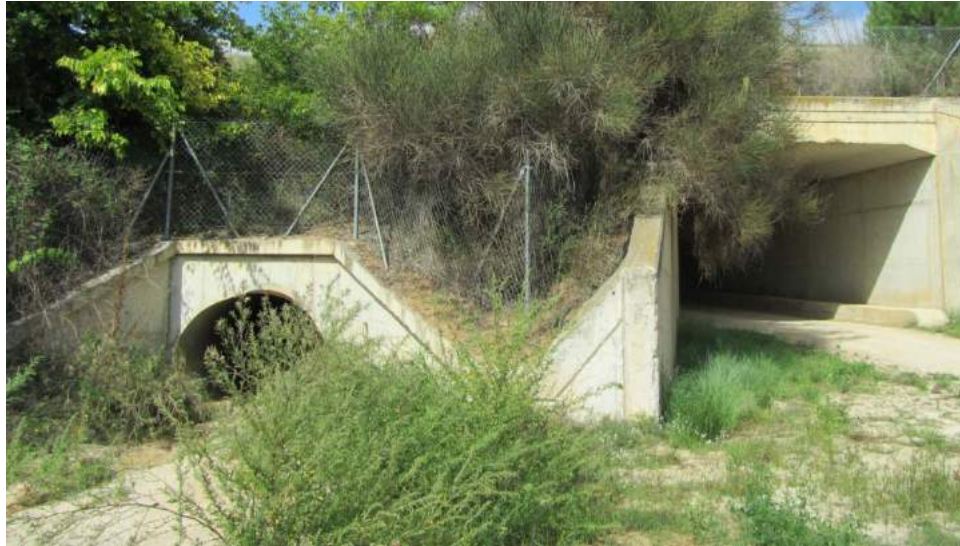
Figura 36. GI_01. Estructura GI_01, torrent de la Gironella (x=458,766.34 / y=4,602,469.22)
