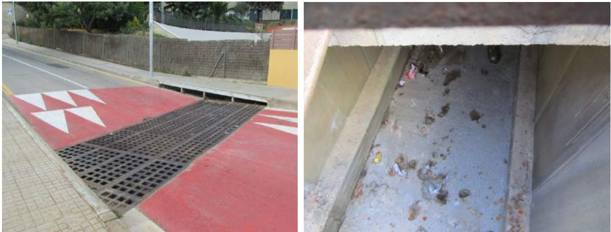
Figura 73. Drenatge urbà a la part alta del torrent del Gorg. La figura de la dreta mostra la part interior.
