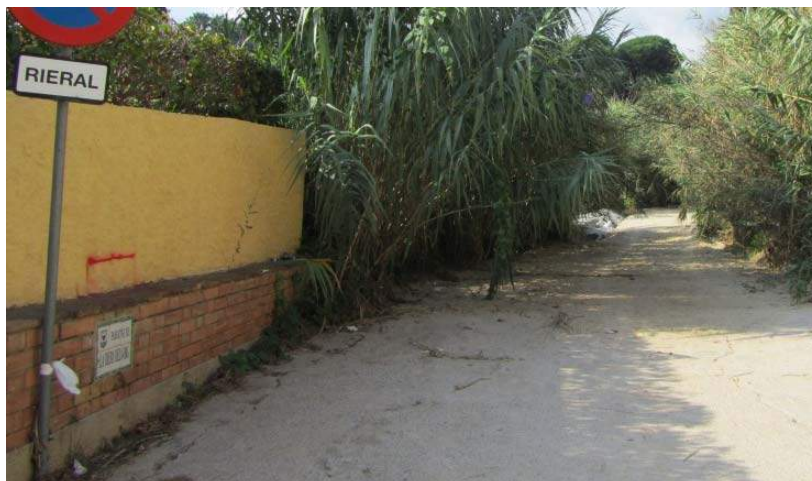
Figura 23. Vista de la llera del torrent del Gorg entre la carretera C-32 i l'entrada a zona urbana.
