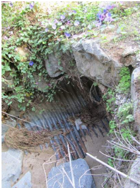
Figura 37. GI_02. Estructura GI_02, torrent de la Gironella. (x=458,938.34 / y=4,601,836.22)
