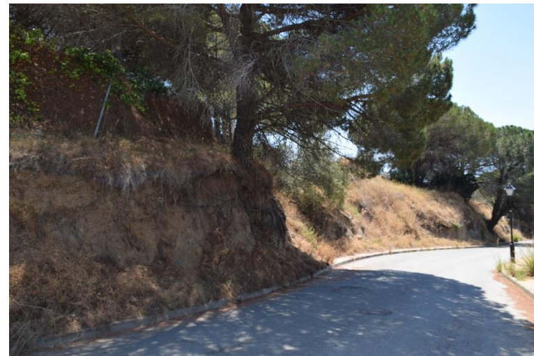
Fotografia 15. Detall de de talús amb esllavissades subàrea De
