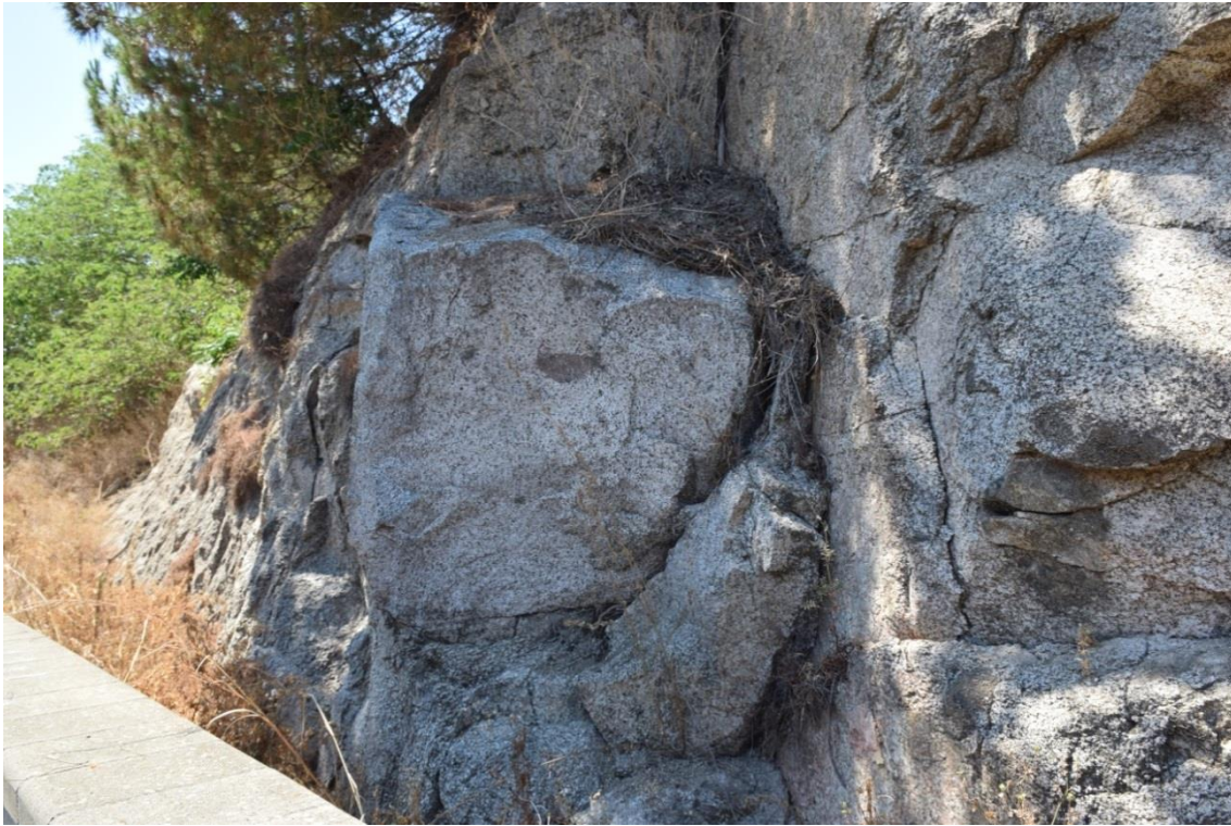
Fotografia 11. Detall del talús a peu de la torre de guaita de Can Valls on s'observa la individualització d'un bloc degut al diaclasat del massís i l'antropització del vessant.
