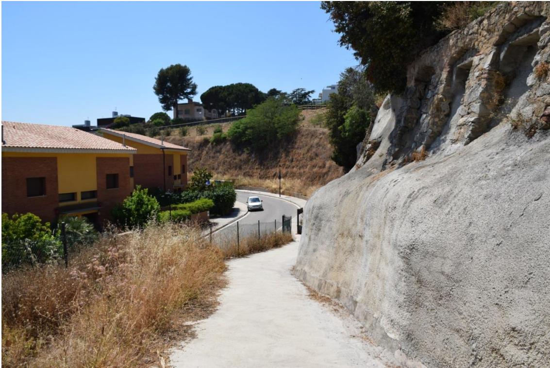
Fotografia 9. Detall de les obres geotècniques (gunitat i reforç) d'estabilització del talús a peu de la torre de guaita de Can Valls
