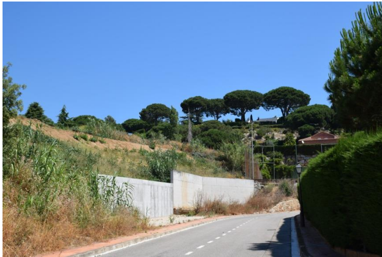
Fotografia 18. Detall de mur de contenció terraplè subàrea De 43
