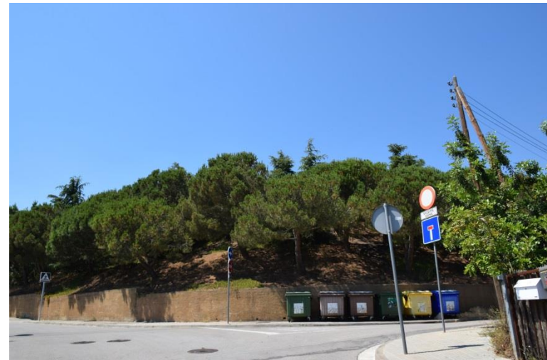
Fotografia 25. Detall de de talús amb mur de protecció subàrea De
