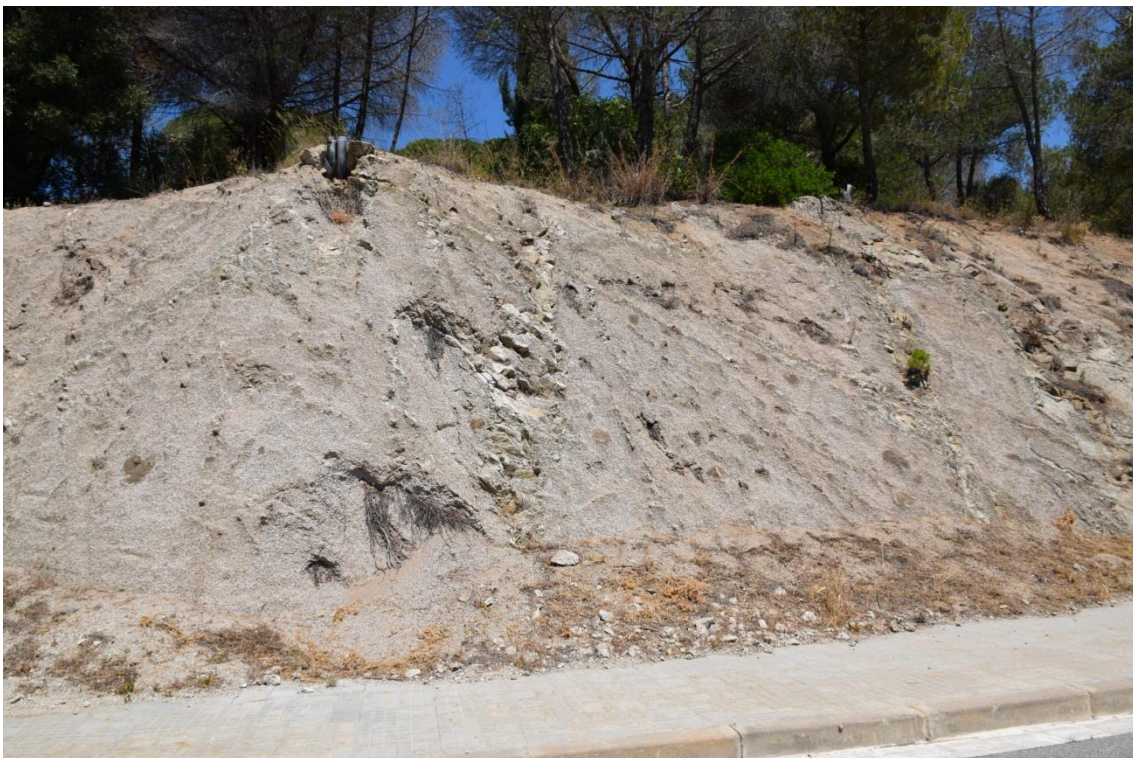
Fotografia 5. Detall del carrer Vinyes d'en Mandrí amb saulons esllavissats sobre la vorera.
