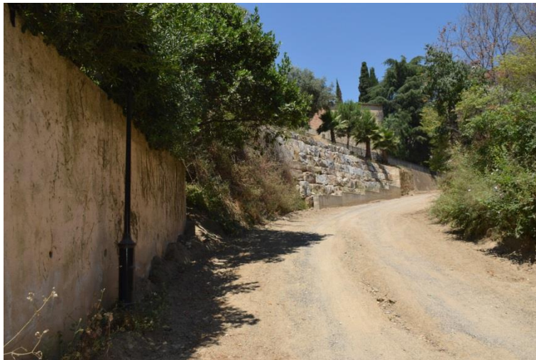
Fotografia 20. Detall de de talús amb mesures de contenció subàrea De
