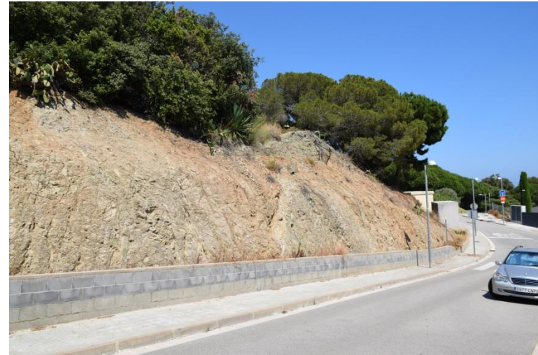
Fotografia 23. Detall de de talús amb mur de protecció subàrea De
