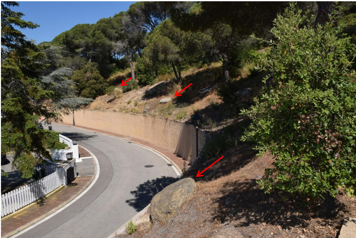
Fotografia 7. Detall d'un dels carrers de la urbanització Supermaresme on s'observen blocs arrodonits en el seu talús superior
