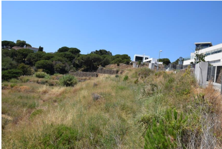
Fotografia 22. Detall de de talús amb mesures de contenció subàrea De
