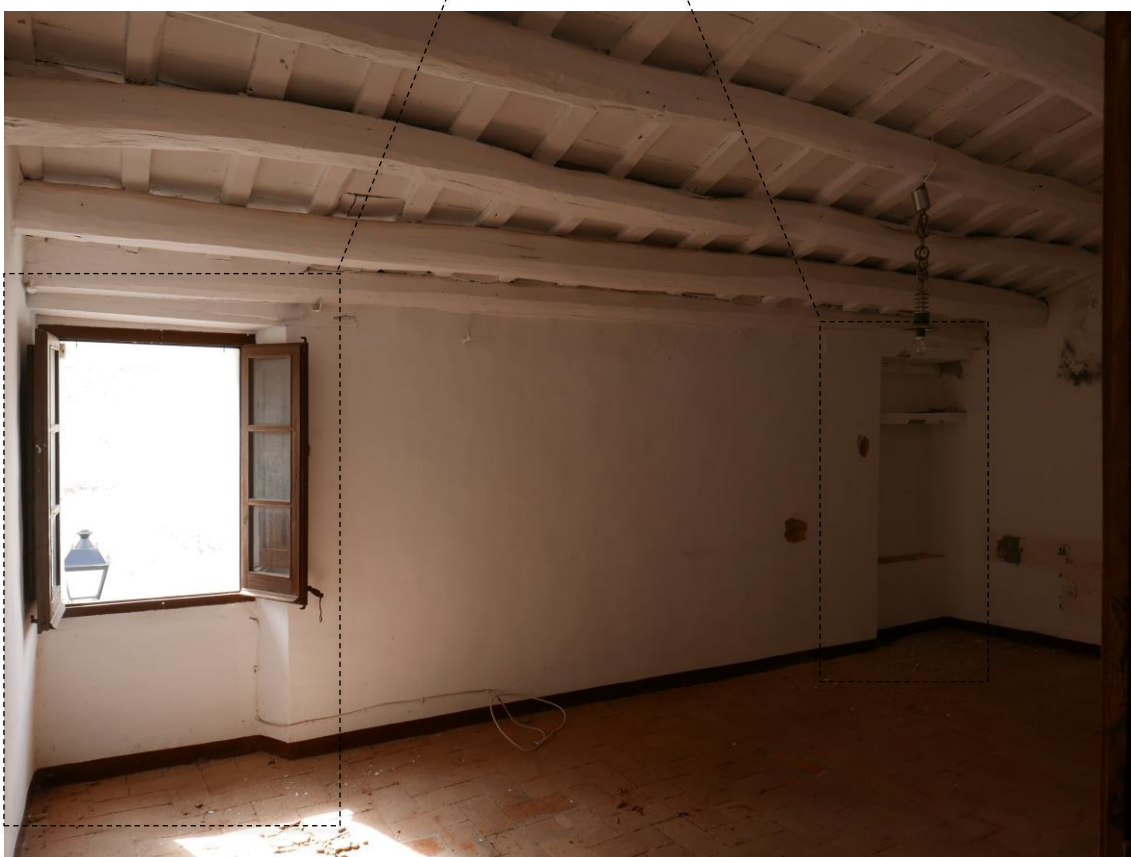
Cara interior de la façana
