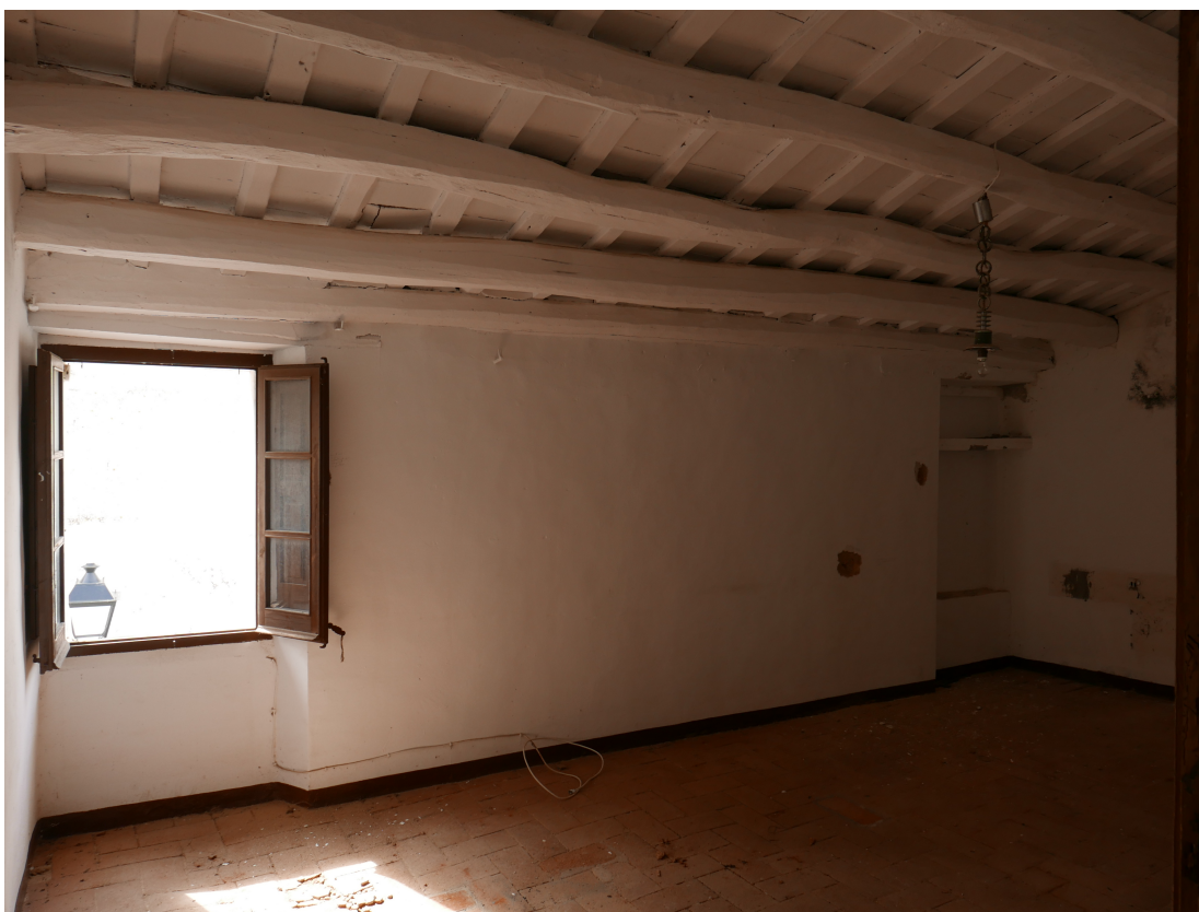
Fotografia de la cara interior de la façana amb la finestra tapiada a l'extrem dret de la fotografia
