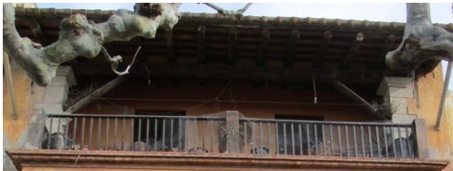
Figura 10. Façana de la planta segona
