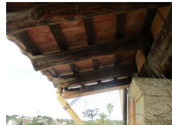
Figura 11. Ràfec de la planta segona
