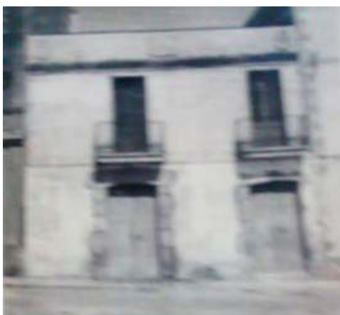
Figura 5. Façanes a la plaça del Poble de les dues cases anteriors a l'actual edificació. Vers 1945
