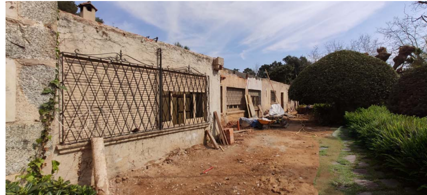
Foto estat actual façana sud del cos lateral
