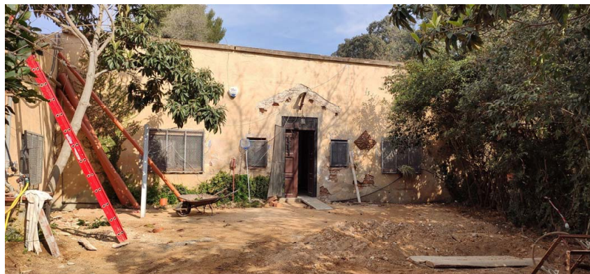
Foto estat actual façana sud del cos lateral del habitatge del masover
