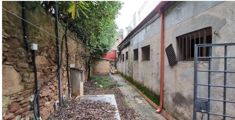
Foto estat actual façana nord
