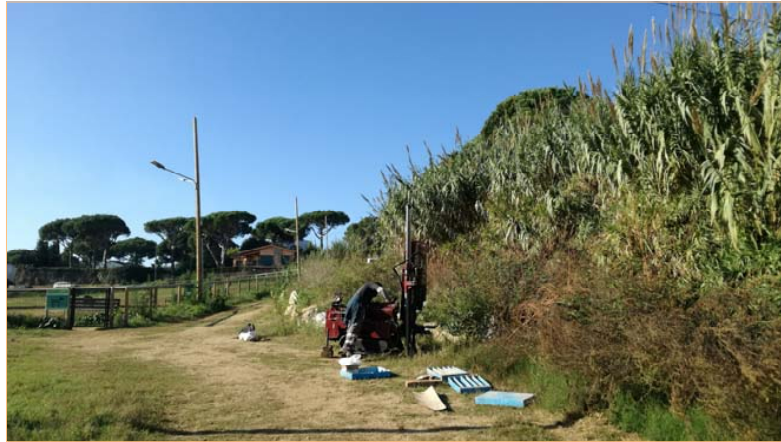
Sondeig S-2. Emplaçament
