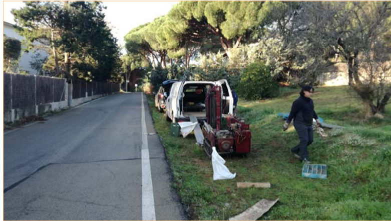
Sondeig S-1. Emplaçament
