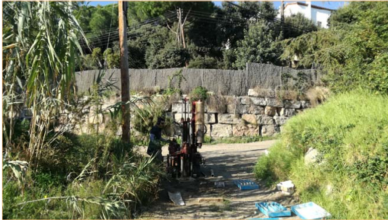
Sondeig S-3. Emplaçament
