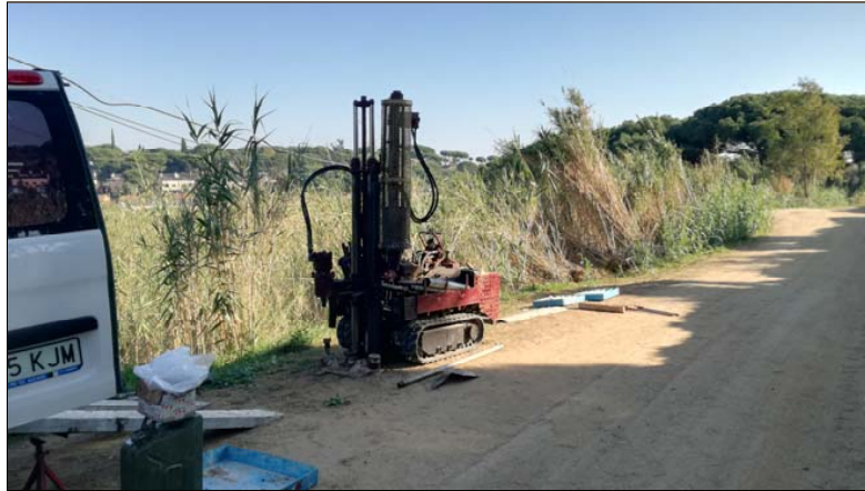
Sondeig S-4. Emplaçament
