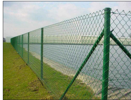
Tancament de la closa amb malla de simple torsió verda
