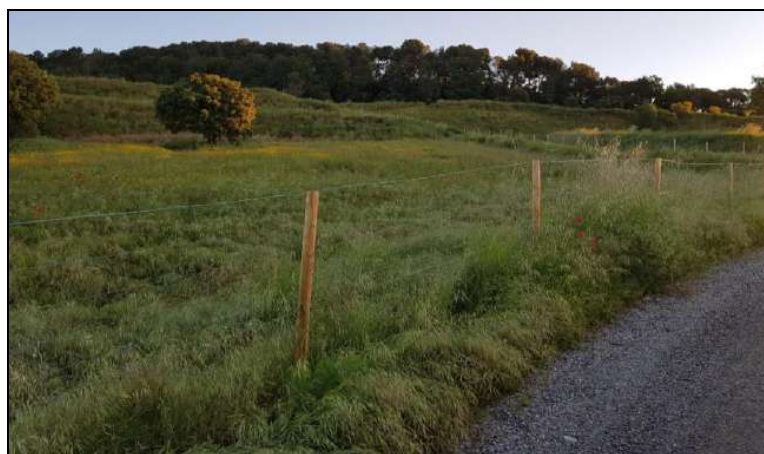
Imatge 3. Exemple de tancat cinegètic. En la present activitat, els pals de fusta de la imatge seran d'acer pintat de color RAL 6015 (o similar).
