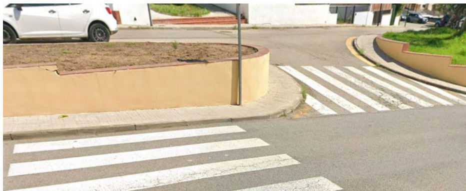
Encreuament de passos de vianants sense rebaixar a l'Avinguda Montalnou
