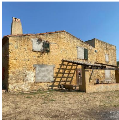
Fotografia de façana
